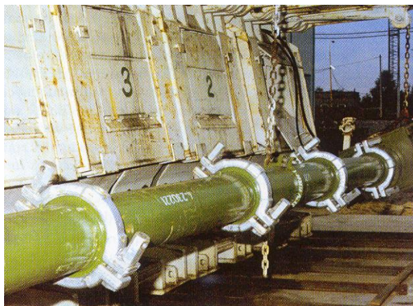
Zafoukávací potrubí za PV
