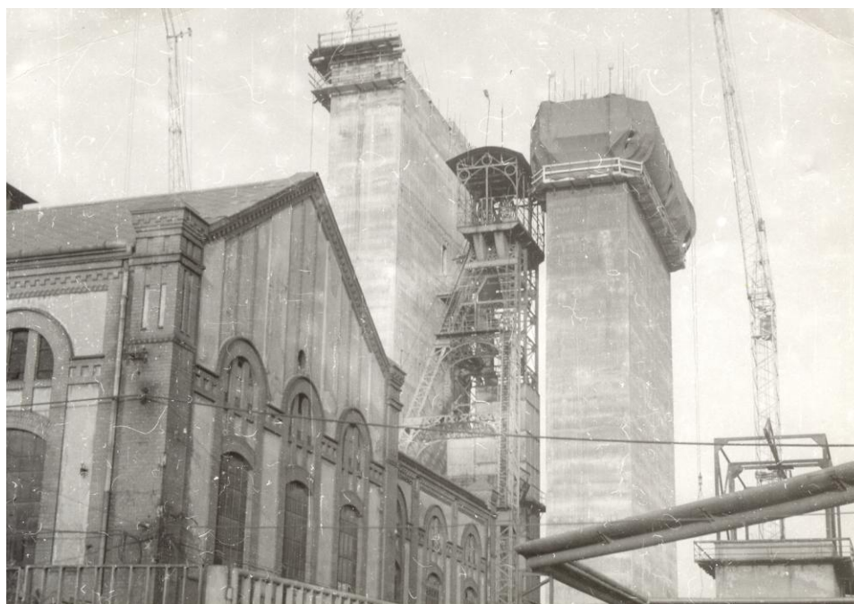
Pohled na výstavbu betonové věže pro skip-jáma č. 3
