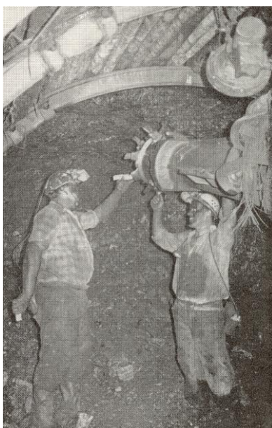
Kontrola řezné části kombajnu
