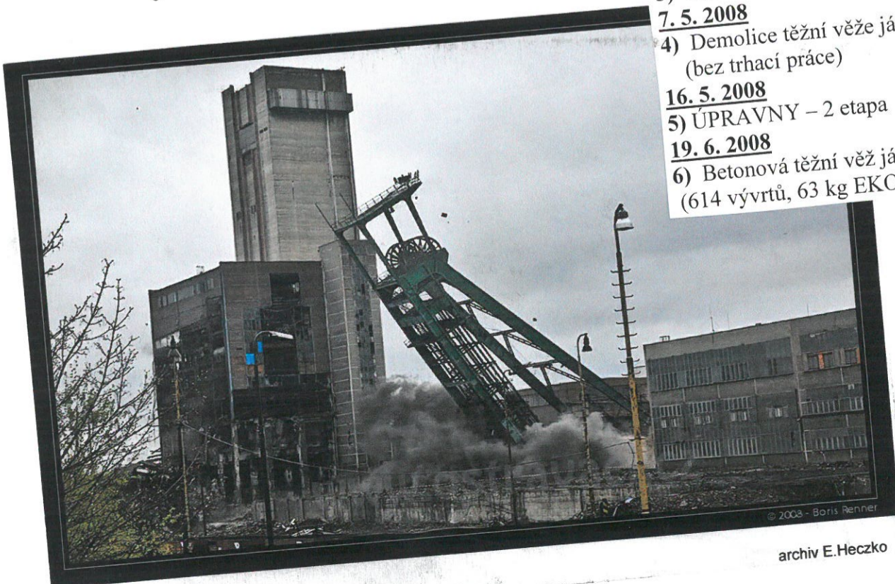
Konec těžní věže jámy č.2
