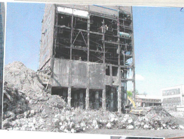
Zkušený střeľmistr firmy ELEX Jiří Eliáš nám prozradil, že odstřel se svou partou připravoval celý týden. Na příložné náložce použili 16 kilogramů Danubitu, 5,6 kilogramu Semtexu 1 A a 36 kusů rozbušek.
