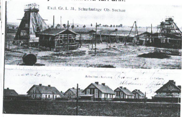
Výstavba jámy František v Horní Suché 1911-12
