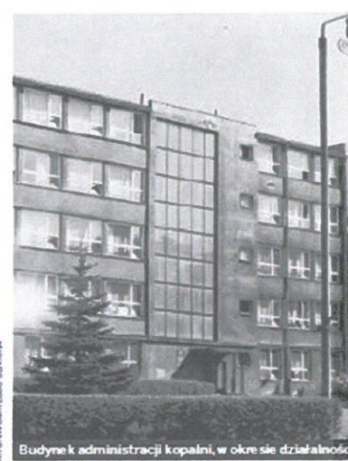
Budynki administracji kopalni, w okresie działalności
