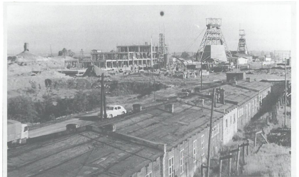
Widok ogólny placu budowy: łaźnie, szyby I i II, miejsce pod cechownię / Fot. autor nieznany (1961) / Arch. rodzina Ostaszewskich
