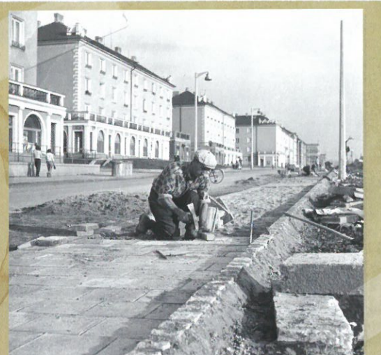
Výstavba chodníku v ulici Na Nábřeží
