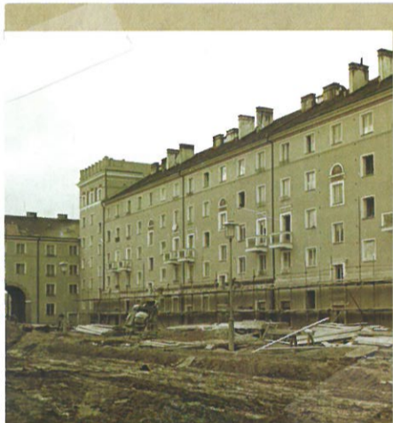
Výstavba domovního bloku v ulici Alšova
