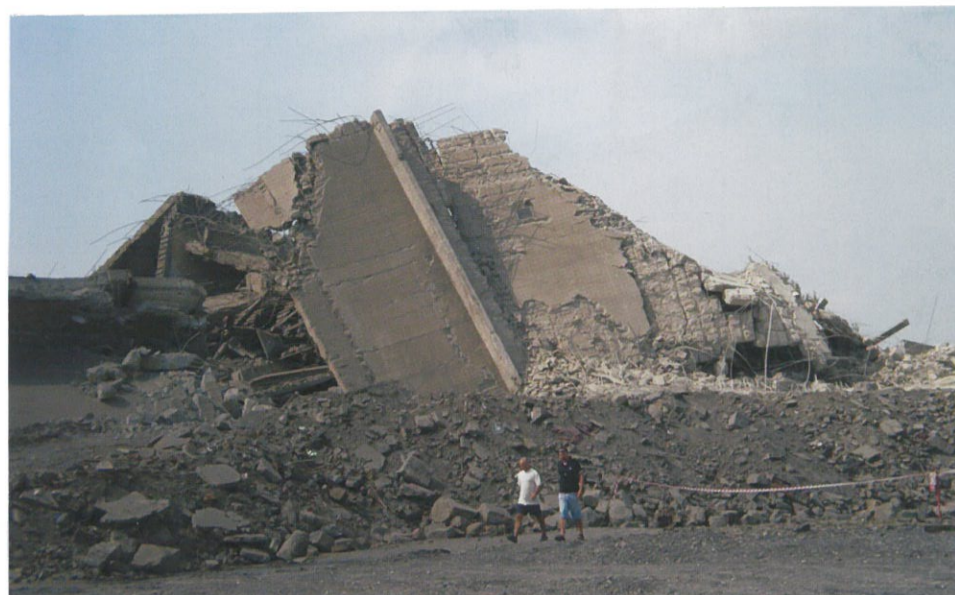
ODSTŘEL SKIPOVÉ VĚŽE DNE 19.6.2008 BYL PROVEDEN VÝBORNĚ
