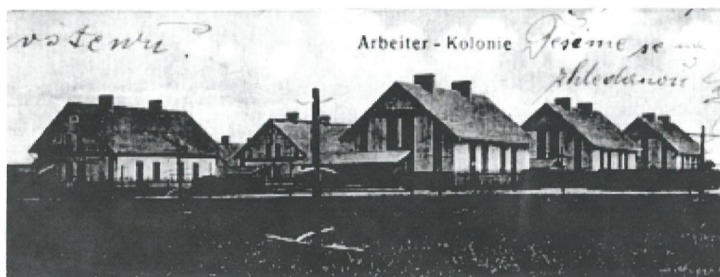
DĚLNICKÁ A HORNICKÁ KOLONIE V HORNÍ SUCHÉ V R. 1919 (DOBOVÁ POKLEDNICE)
