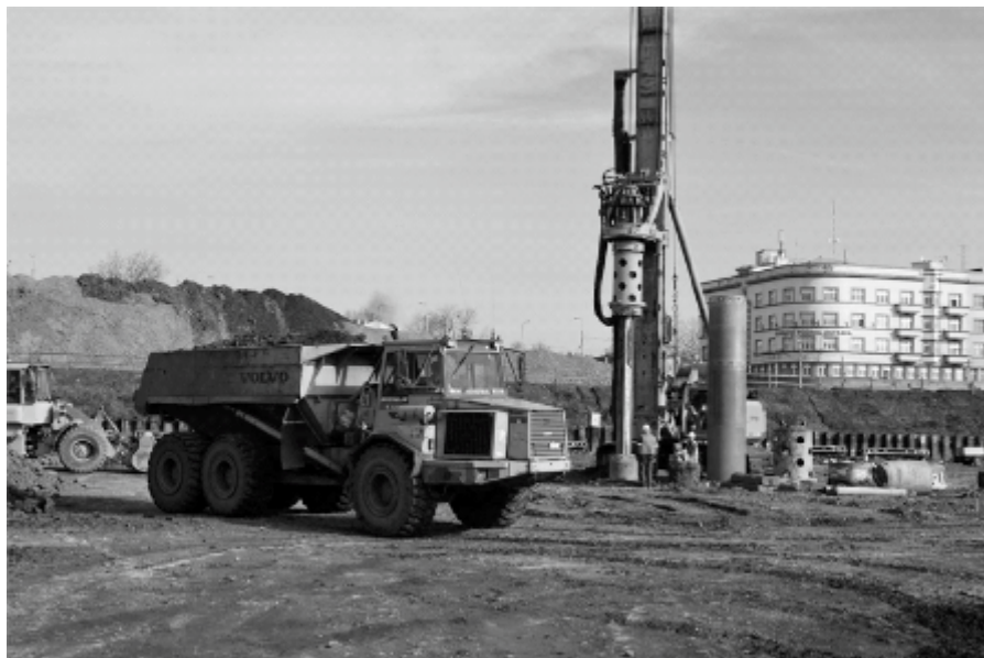
Obr. 1: Sanace území bývalé koksovny Karolina. Zdroj: Archiv AWT Rekultivace, a.s.
