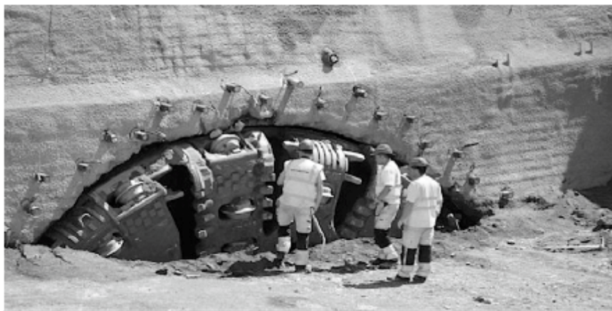
Obr. 2: Řezná hlava razicího stroje se po 500 dnech částečně vynořila na povrch. Foto Ivan Blažek
