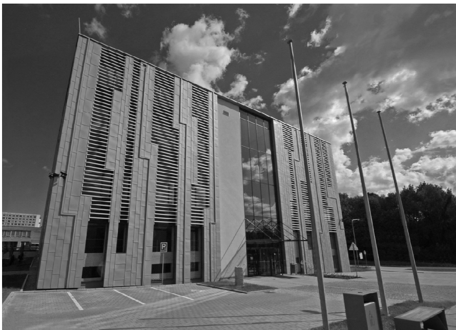
Obr. 1: Budova superpočítačového centra v areálu VŠB-TU Ostrava
