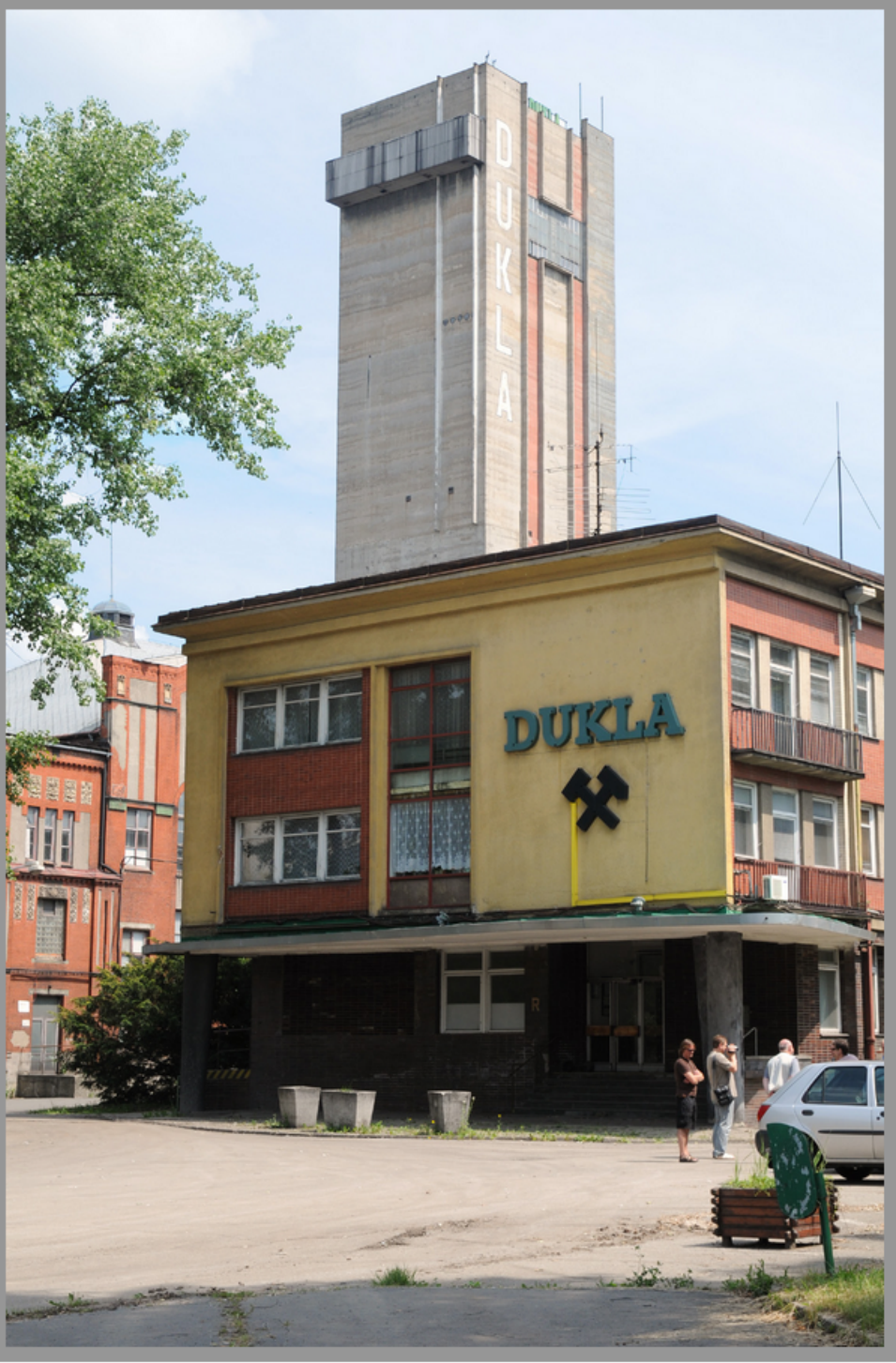
Betonová těžní věž jámy č. 3, dostavěná v roce 1983 (archív Dolu Dukla)
