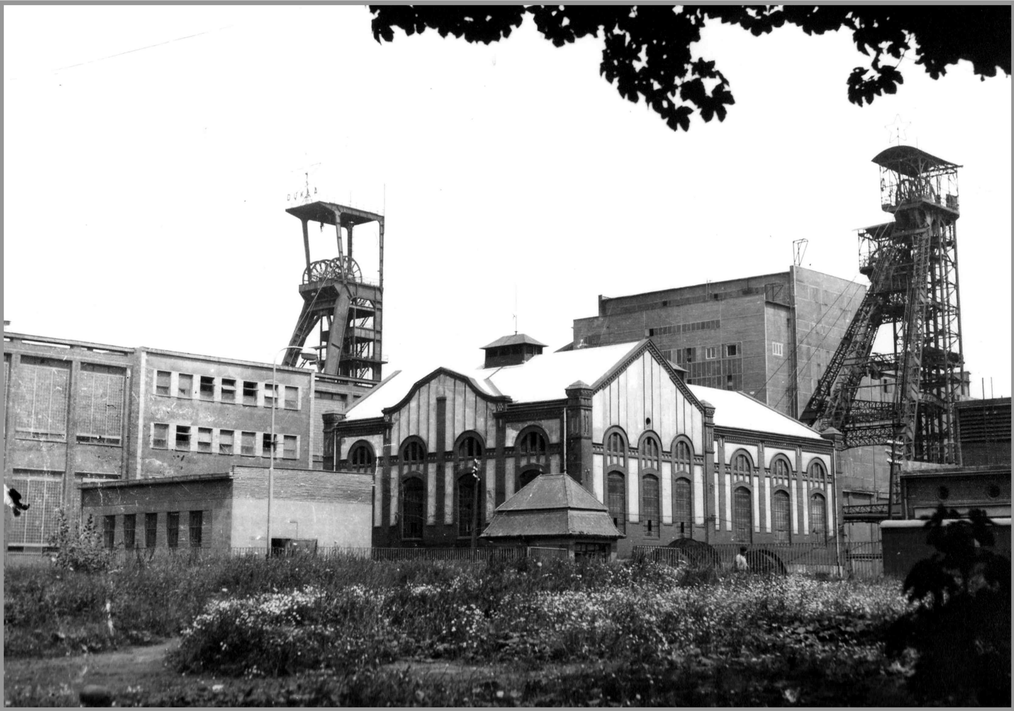
Důl Dukla během rekonstrukce v letech 1958-1965 (archív Dolu Dukla)
