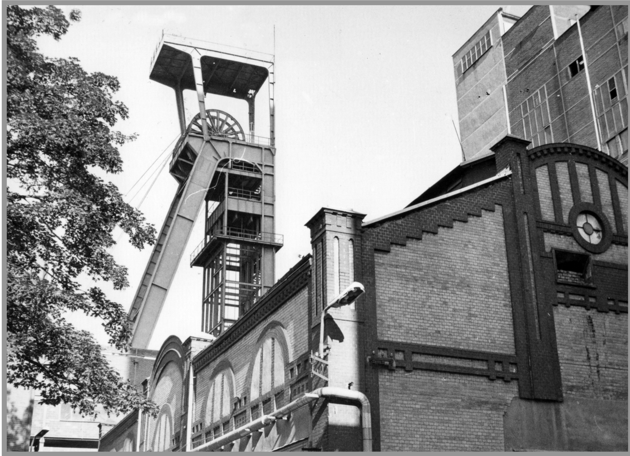
Věž č. 2 - vtažná - v roce 1965 (archív Dolu Dukla)
