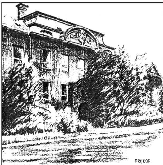
Budova bývalého lycea ve Slezské Ostravě-Hladnově sloužila převážně výuce hornictví
