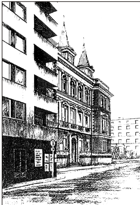
Bývalá hlavní budova fakulty strojní v Ostravě, v pozadí je budova kostela a kavárna Fenix. V letech 1945 až 1952 katedra úpravnictví.
