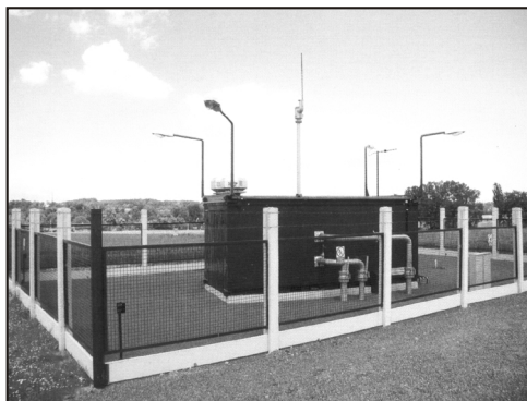
Kontejnerová kompresorová odsávací stanice pro těžbu důlního plynu, nasazovaná v dobývacích prostorech uzavřených dolů.
