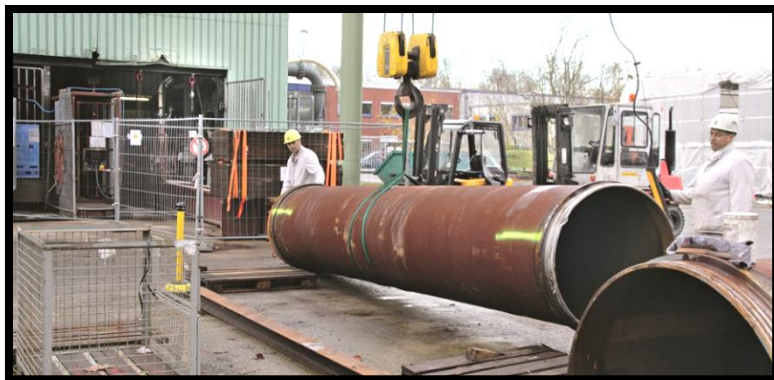
Obr. č.: 4 – Plášťové roury o průměru 1 m a délce 6 m umísťované do šachty (zdroj viz použitá literatura)
