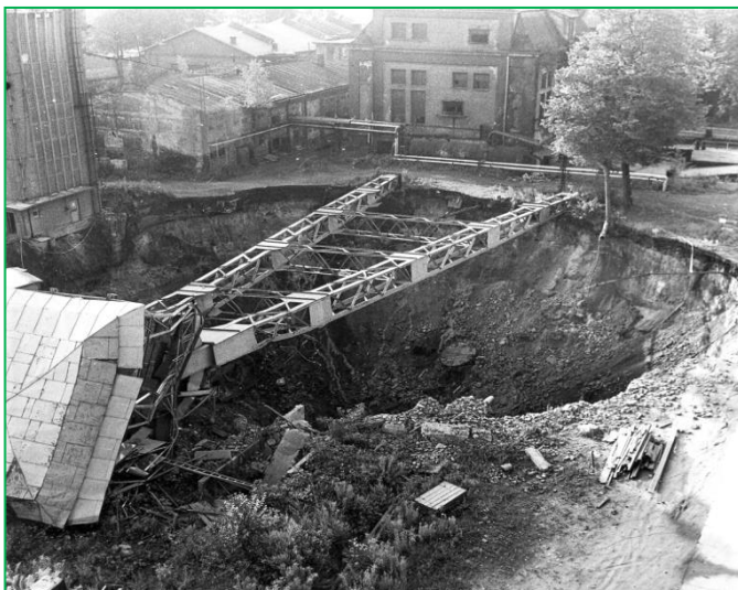
Dva snímky zachycující stav po zřícení těžní věže na Hedvice.
